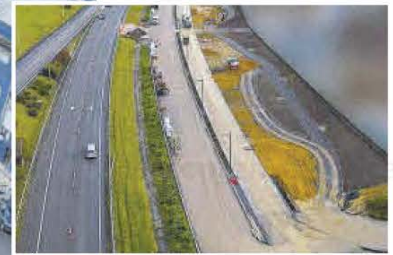
Detalle de las obras de la margen derecha de la autopista. | Cedida a LNE
