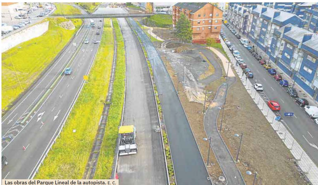
Las obras del Parque Lineal de la autopista. E. C.
