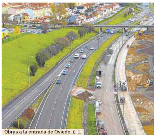
Obras a la entrada de Oviedo. E. C.
